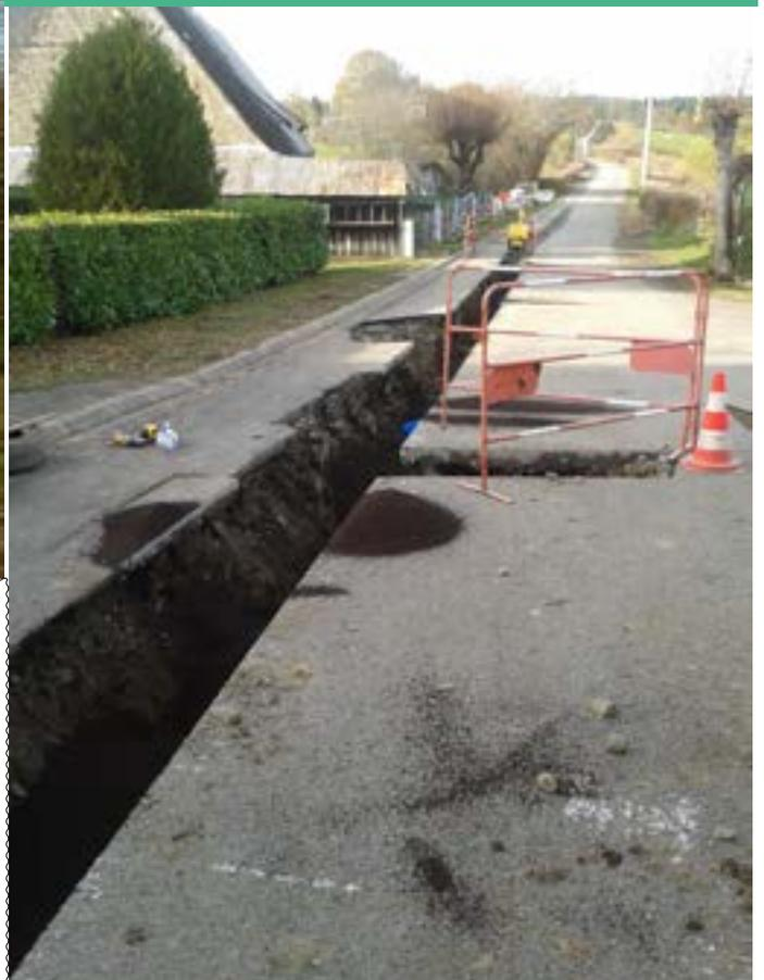
*Prévu de puis plusieurs années, le chantier d'assainissement de SERROUX se déroule selon le calendrier prévu pour la mise en place d'un assainissement collectif, le renforcement du réseau d'eau potable, et l'enfouissement des réseaux secs.*
