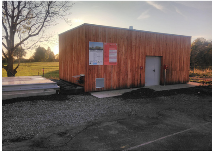
Bâtiment de la chaufferie
