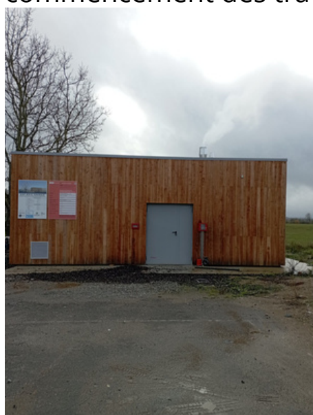
Bâtiment de la chaufferie
