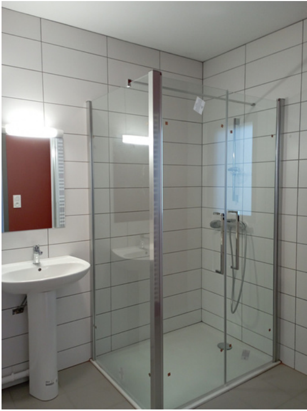
Salle de douche d'un logement
