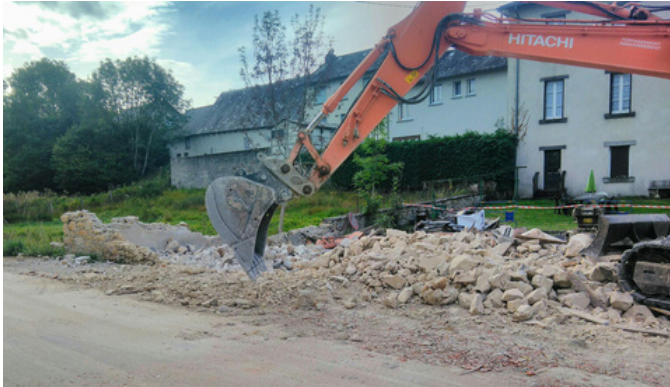
En fin de travaux
