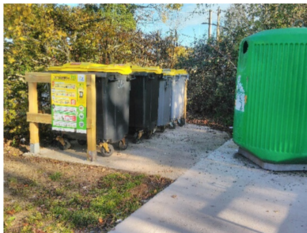
Entourage des bacs et dalle en béton
